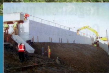
Lichtgewicht wegverbreding 4 meter verticaal zonder talud
